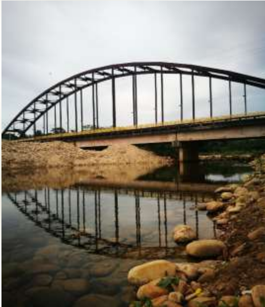
Puente Rio Tame
